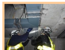
導水樋設置作業
