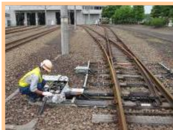
電気転てつ機検査
