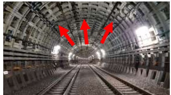
③トンネル上部
