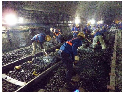
人力による線路設備復旧
