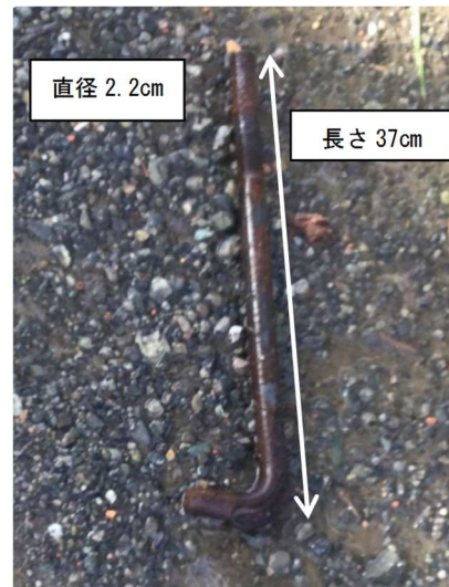
写真2 発見したボルト
