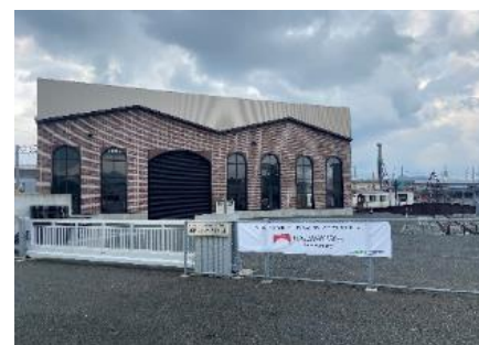
盛岡車両センター SL検修庫
