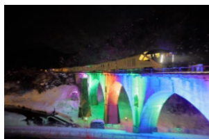
釜石線 宮守—柏木平間
