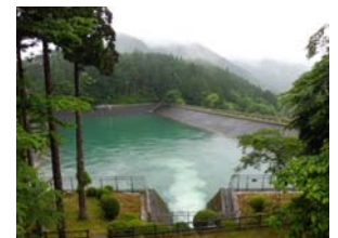
氷川発電所調整池（イメージ）
