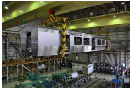
車体のクレーン移動
