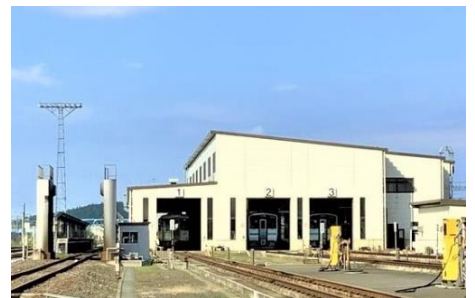
【八戸運輸区検修庫】
