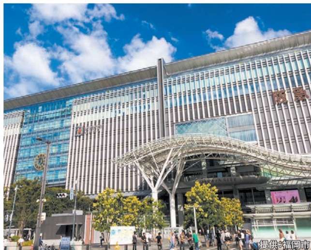
大型商業施設JR博多シティと直結しています。
