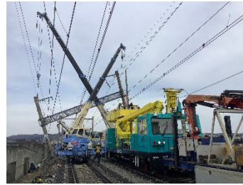
電柱復旧作業
