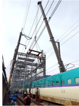
脱線復旧作業
