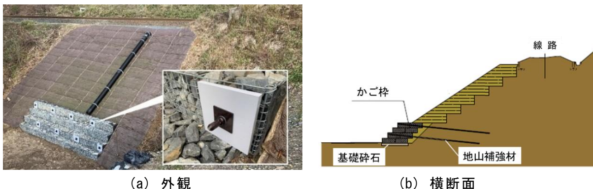
図2 強化復旧法による盛土の復旧事例
