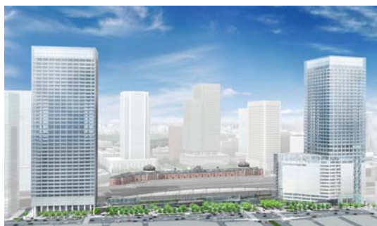
東京ステーションシティ(ノースタワー 期)
