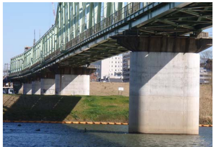
橋脚耐震補強
