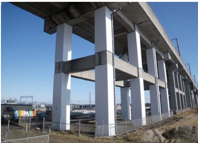
高架橋柱耐震補強
