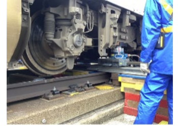
復旧作業の様子
