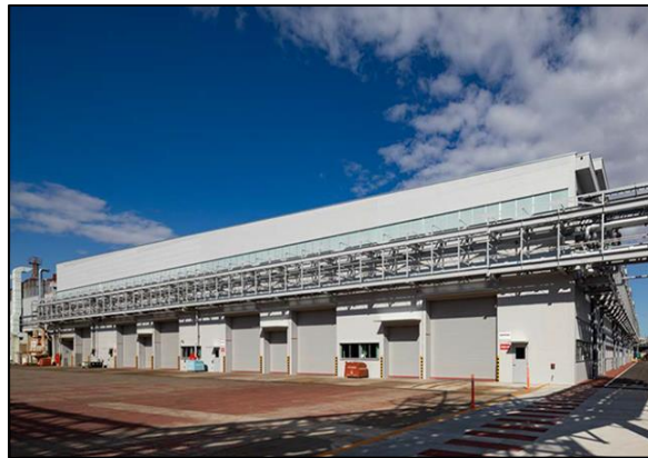
東車体修繕場
