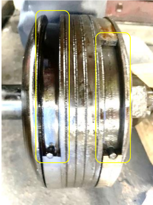
ピストンリング損傷(黄枠部)
