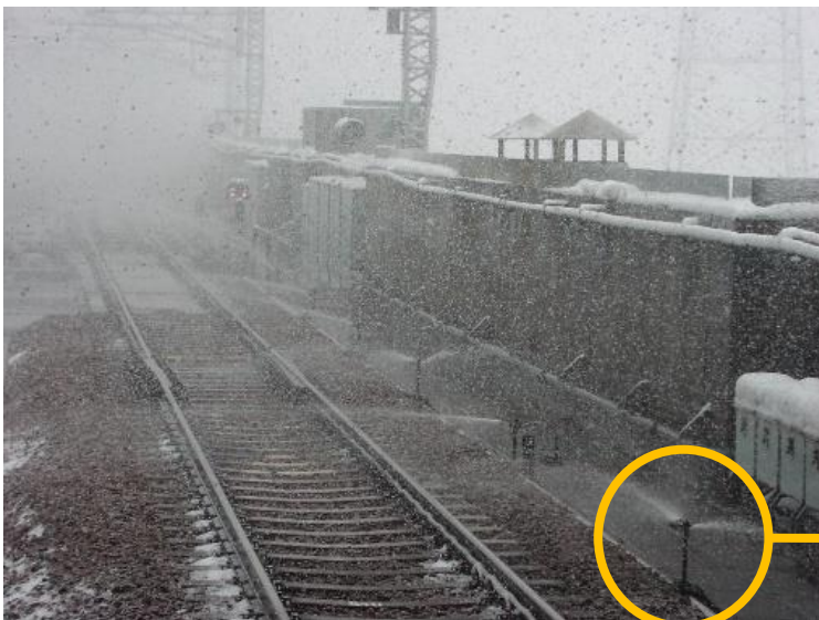
新幹線高架上の散水消雪設備（スプリンクラー）
