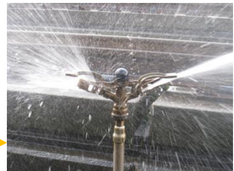
新幹線高架上の散水消雪設備（スプリンクラー）
