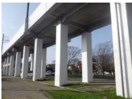
▲千葉中央駅～千葉寺駅間 高架橋耐震補強工事
