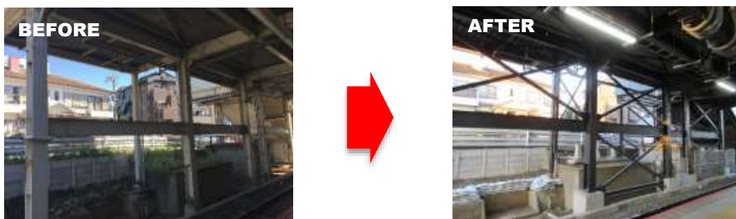
▲耐震補強工事イメージ(東中山駅)
