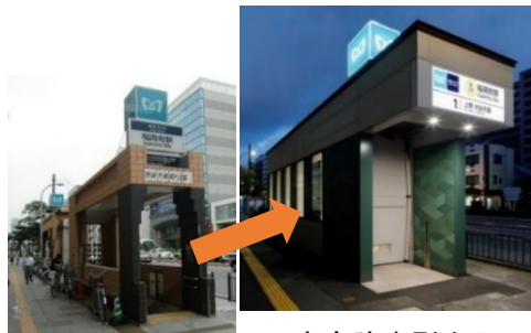
▲完全防水型出入口
