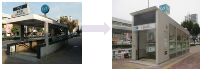
▲完全防水型出入口
