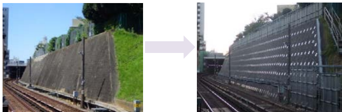
◀石積み擁壁補強
