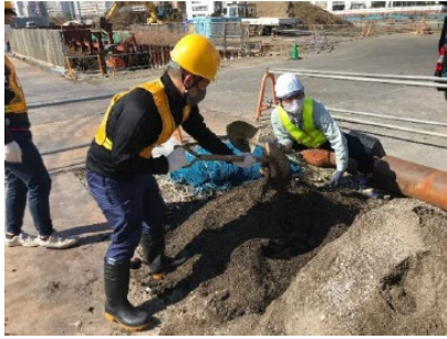
【開発予定地の掘削残土の再利用】
