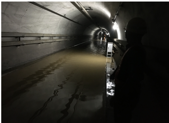
8月14日(土)11:00 現在 御陵駅付近トンネル内部の浸水の様子
