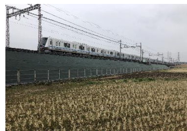
改修後の法面の様子
