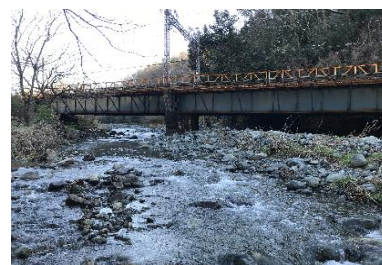
第2四十八瀬川橋梁（渋沢駅～新松田駅間）
