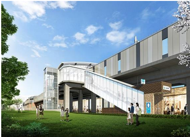
しょうぶ沼公園に直結する駅出入口
