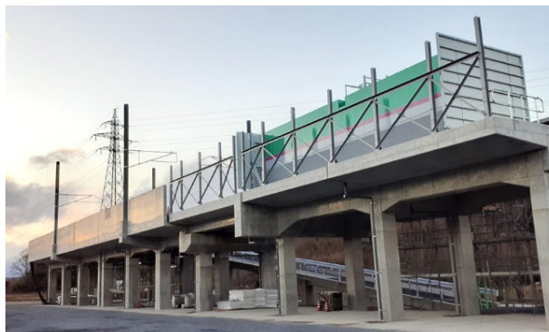
コンクリート橋
