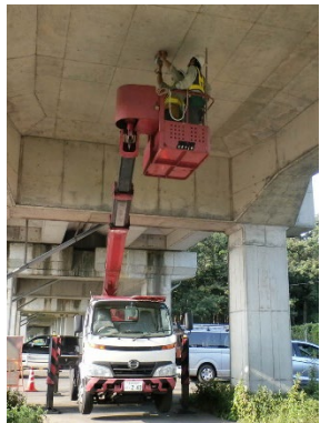
現状(高所作業車による計測)
