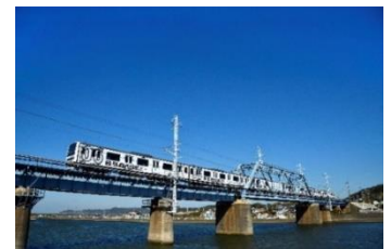
内房線 上総湊-竹岡駅間
