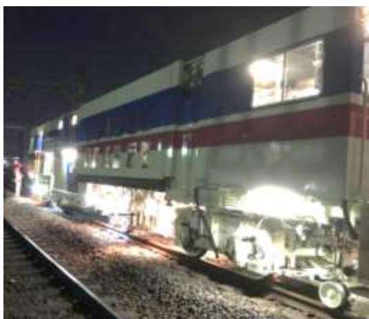
〈線路保守作業の様子〉
