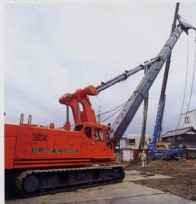
リーダ起伏作業
