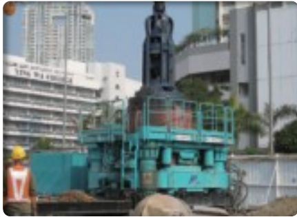
地中障害物切削
