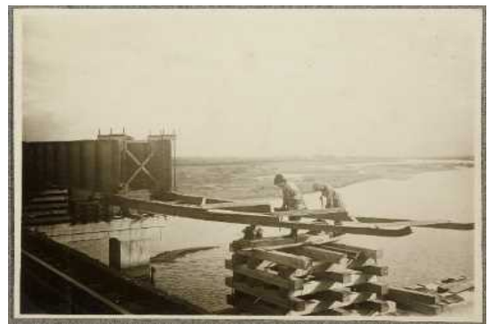
▲下神崎川橋梁架設工事写真(大阪駅～尼崎駅間)1926(大正15)年
