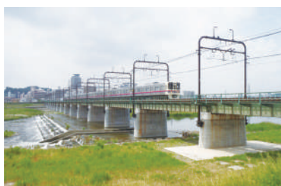
多摩川橋梁耐震補強
