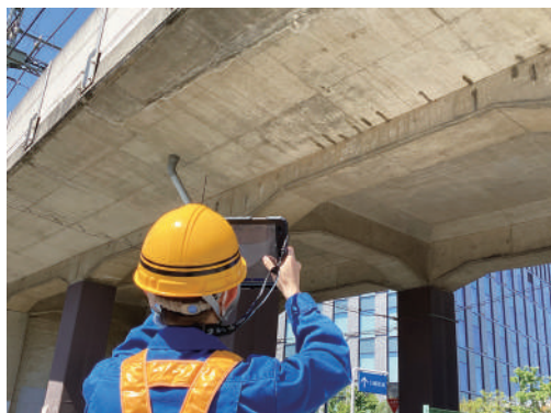
タブレットによる現場での検査
