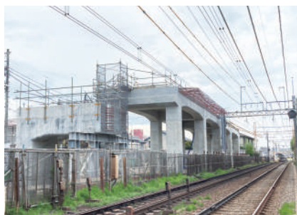
連続立体交差事業
