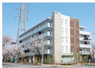
スマイラス聖蹟桜ヶ丘 (サービス付き高齢者住宅)
