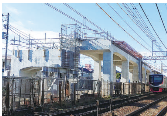
高架橋構築箇所（明大前駅付近）
