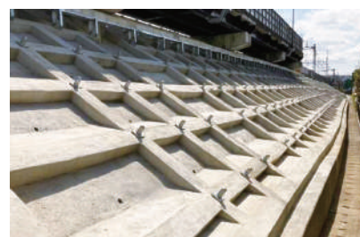
盛土区間耐震補強
