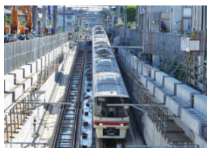
調布駅付近地下化切替工事
