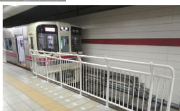
転落防止固定柵
