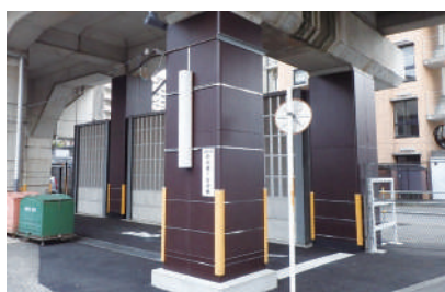
高架橋柱耐震補強
