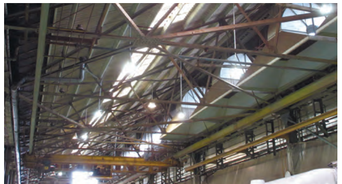
水銀灯・蛍光灯のLED化推進
