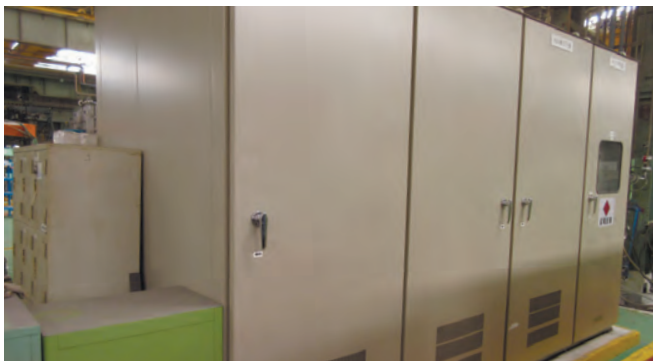
変圧器の更新
