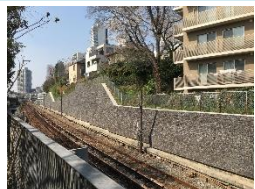
2019年度完了 ▲石積み擁壁補強(丸ノ内線)
