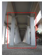
2020年度完了 ▲高架橋柱補強
