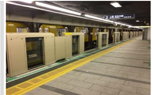
ホームドア設置後のホームの状況(銀座線浅草駅)
