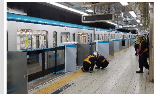
ホームドア設置作業の様子(東西線九段下駅)
