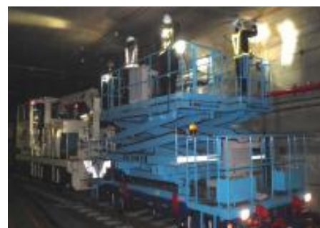
高所作業車による特別全般検査
