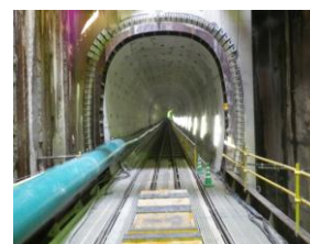
小竹向原～千川駅間 連絡線設置工事
