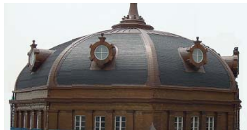
ドーム屋根(国産のスレートを使用)
