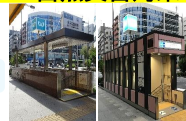
▲大規模浸水対策工事前 ▲大規模浸水対策工事後
