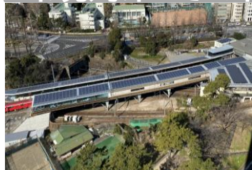
▲丸ノ内線四ツ谷駅太陽光発電システム
