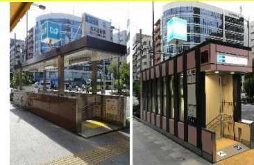
▲大規模浸水対策工事前 ▲大規模浸水対策工事後
