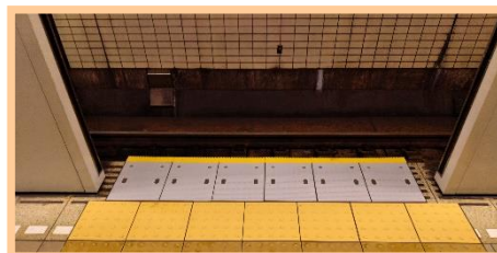
南北線仙台駅隙間調整材設置
