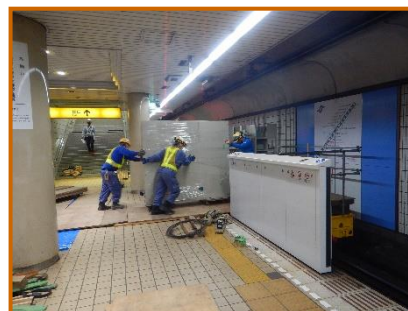
夜間工事の様子
