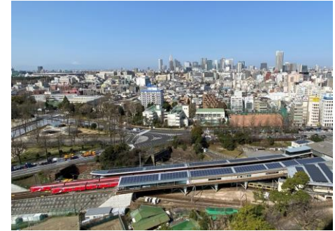
▲丸ノ内線四ツ谷駅の太陽光パネル
