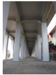
高架橋柱補強
