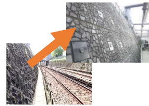
石積み擁壁補強
