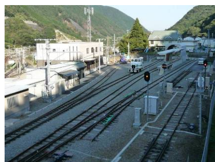
技能教習所整備
