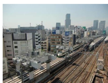
東北縦貫線整備
