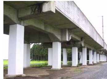
高架橋耐震補強
