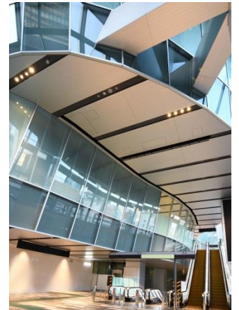
▲3階イベントスペース外観 現在の様子(工事中)
