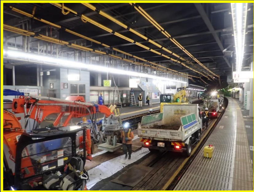
土留杭設置状況 (芦花公園駅)
