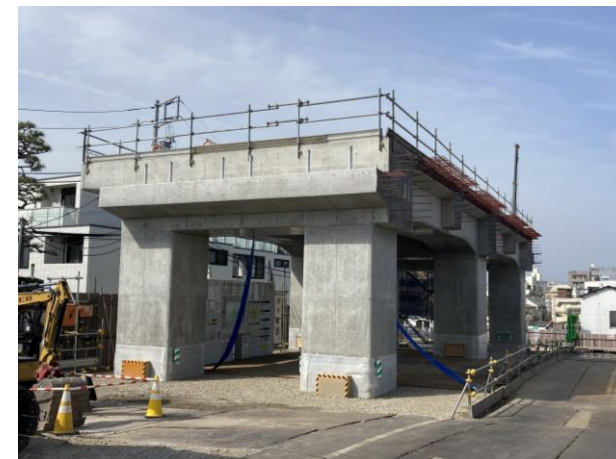
躯体構築状況 (明大前駅付近)
