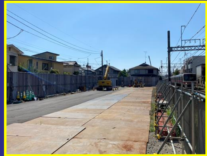
ヤード整備工
