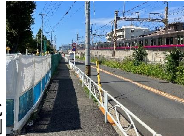
付替道路切替前の現況 (南側道路)
