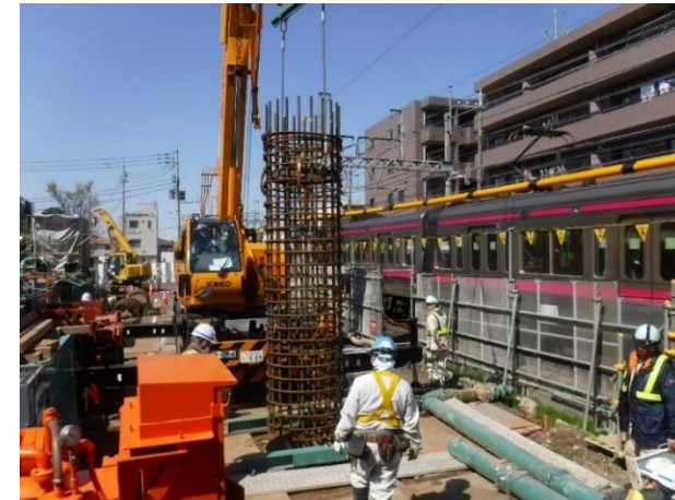
基礎杭構築状況 (千歳烏山駅～仙川駅間)
