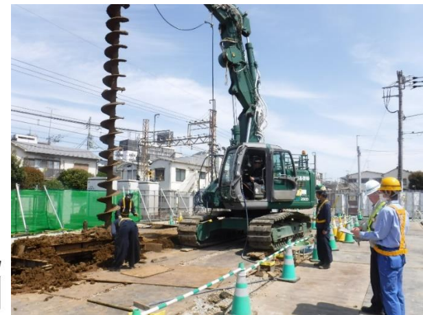
土留設置状況 (明大前駅付近)
