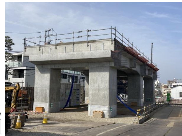
躯体構築状況 (明大前駅付近)
