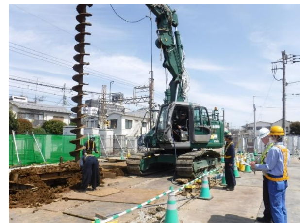
土留設置状況 (明大前駅付近)
