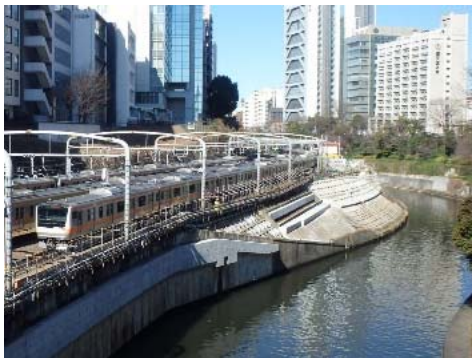
耐震補強対策の実施
