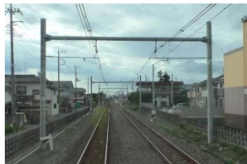
電力設備の強化 (インテグレート架線)
