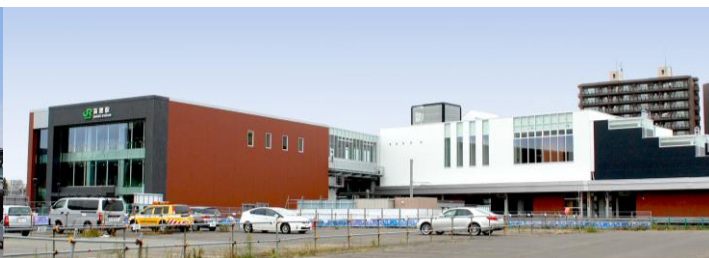
【新駅舎(右側)、自由通路南口昇降棟(左側)】
