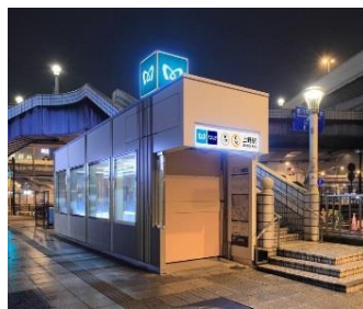
▲浸水対策後（上野駅）
