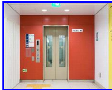
▲エレベーター1ルート整備
