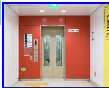
▲エレベーター1ルート整備
