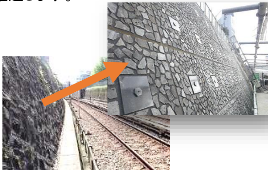
▲石積み擁壁補強
