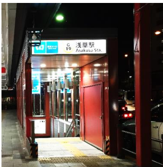
▲浸水対策後(防水扉設置)
