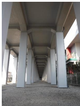
▲高架橋柱補強
