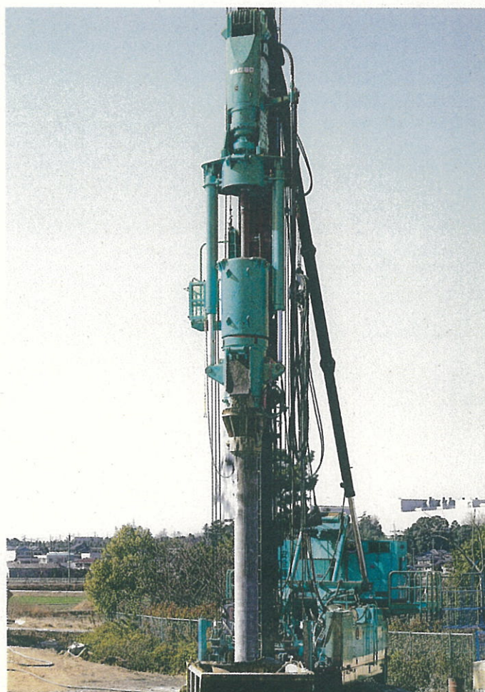
NAS80 (5TONモンケン付) 中掘作業中のDHP-85
