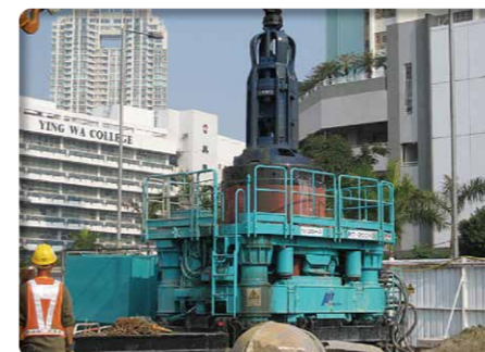
地中障害物切削
