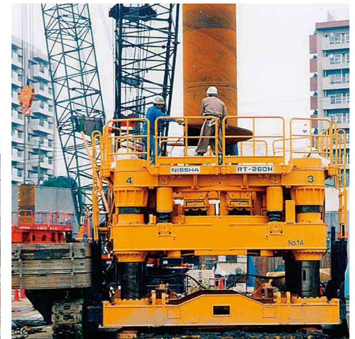
RT-260Hによる鋼管杭施工状況
