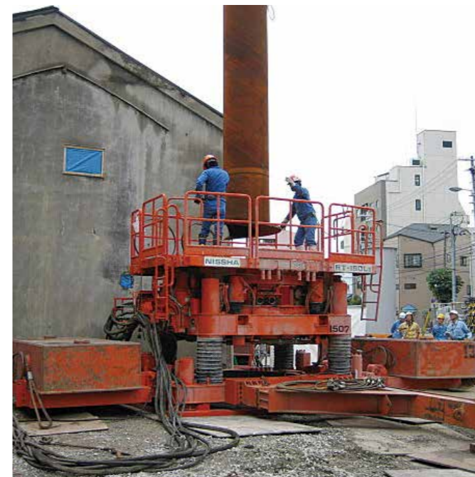
RT-150LIIによる鋼管杭施工状況
